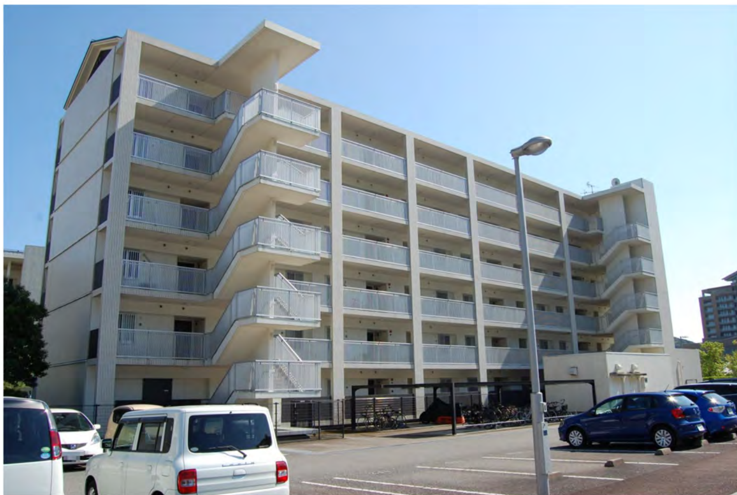
世帯用・宿舎外観
